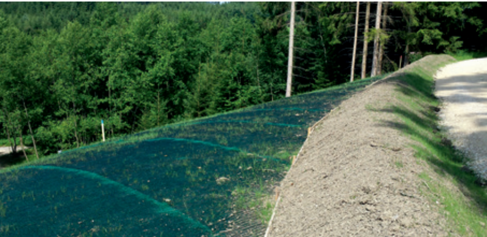
Abb. 4: Beispiel für die Ausführung eines Oberflächenwassermanagements bei der Sanierung einer Quelfassung, die ursprünglich von Fremdwasserzutritten entlang eines Forstweges und seines Begleitgrabens betroffen war
