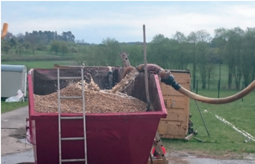
Abb. 6: Absaugen vom Kiesmaterial aus dem Ringraum
