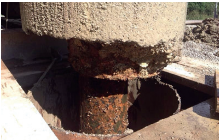
Abb. 4: Bergung eines vorher überbohrten alten Sperrrohres mit Brunnenausbaurohr
